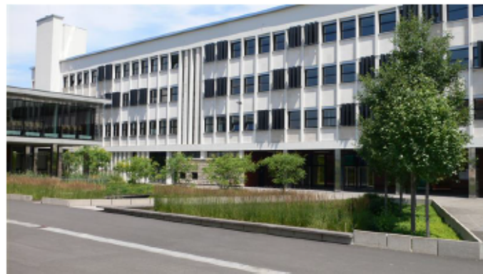
Jardin de pluie au Lycée Saint Exupéry à Lyon (Photo CERTU) :
