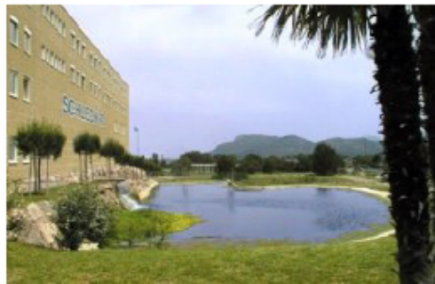
Bassins d'orage paysagers, ZAC de Ferrières, Le Muy à Marseille (photo sté HGM environnement)
