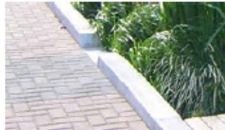
Jardin de pluie à Portland (Oregon-USA) : Ce dispositif permet de déconnecter les eaux de ruissellement des voiries (trottoir) et du bâtiment (photo Mairie de Portland)
