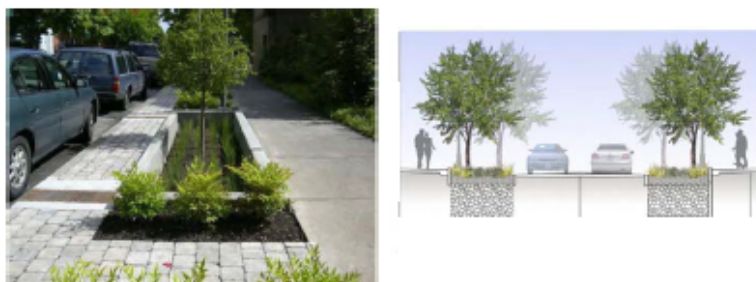
Noues urbaines à Portland (Oregon-USA) : Ce dispositif permet une déconnexion complète des eaux de ruissellement de la chaussée et du trottoir. À noter que les eaux de ruissellement de chaussée sont traitées par les noues basses et les eaux de ruissellement du trottoir par des noues plus hautes (photos et coupe : Mairie de Portland)
