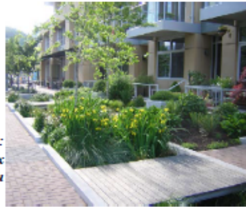
Jardin de pluie à Portland (Oregon-USA) : Ce dispositif permet de déconnecter les eaux de ruissellement des voiries (trottoir) et du bâtiment (photo Mairie de Portland)
