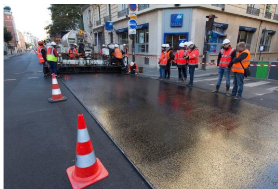
Photo 33. Travaux de revêtement anti-bruit et anti-chaleur (Ville de Paris)
