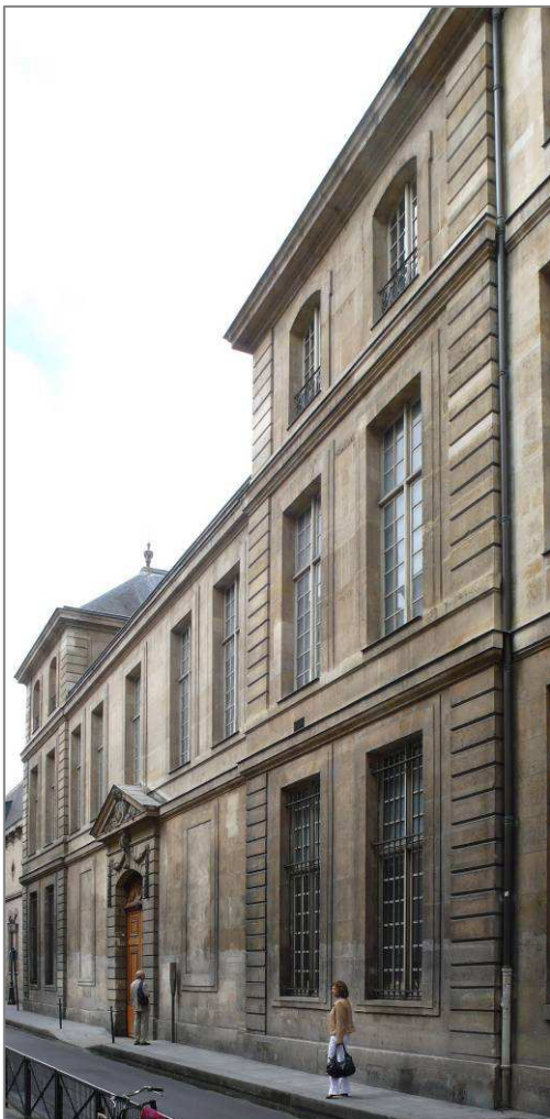
1688, hôtel Le Peletier, 29 rue de Sévigné, façade sur rue
