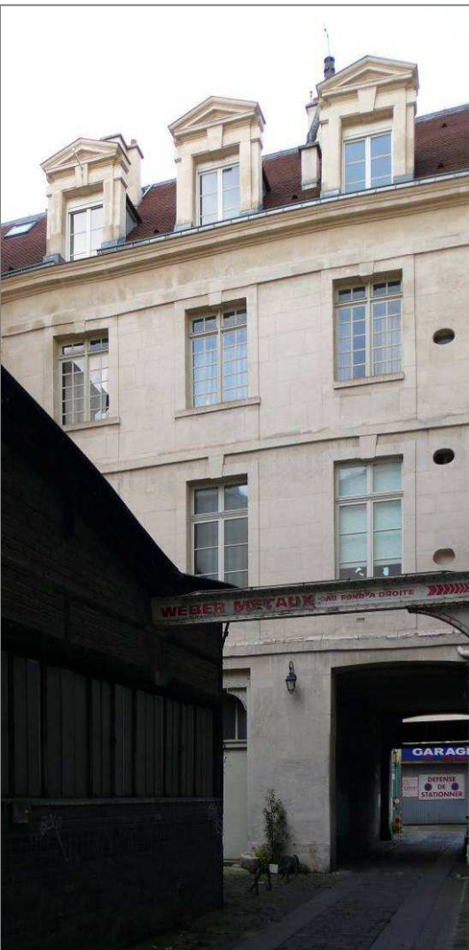
1640, cour de l'hôtel Boulin, 68 rue de Turenne
