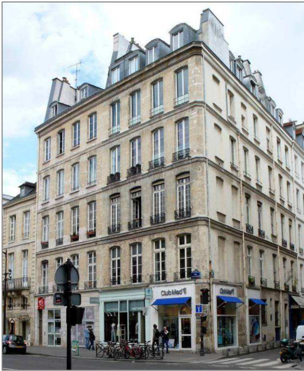
1742 , 2 immeubles 28 et 30 rue Saint-Antoine
