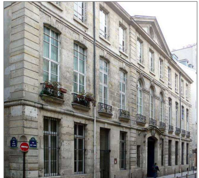
1738, 12 rue St Merri, Hôtel Le Rebours
