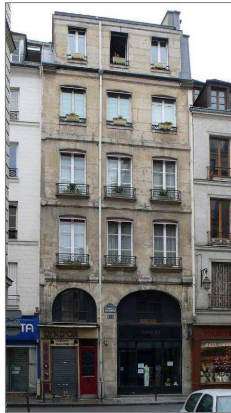
1746 , 153 rue du Temple, immeuble Laisné
