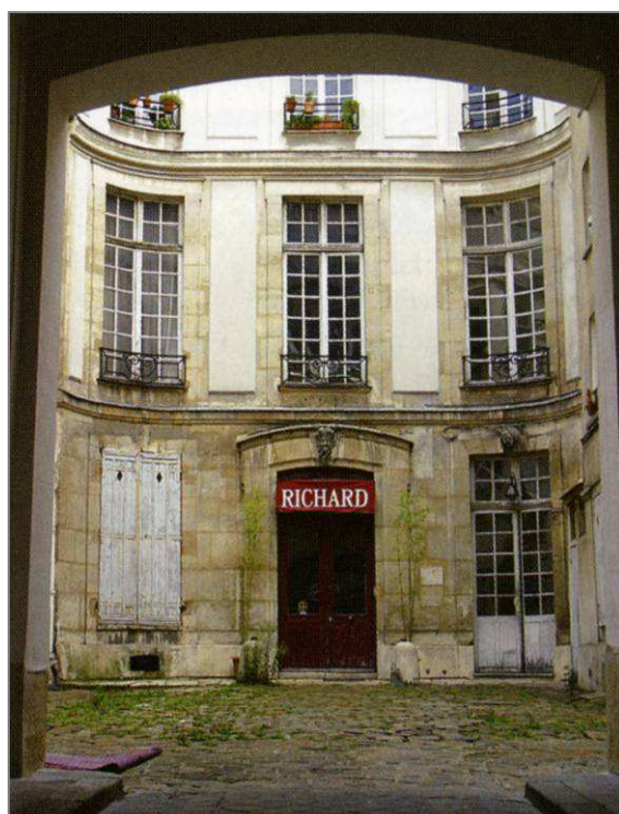
1704, rue Charlot, Hôtel de la Garde
