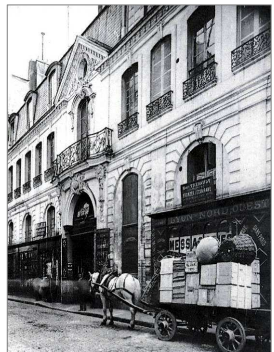
1740, 31 bis rue des Francs-Bourgeois, Bâtiment sur rue de l'hôtel d'Albret
