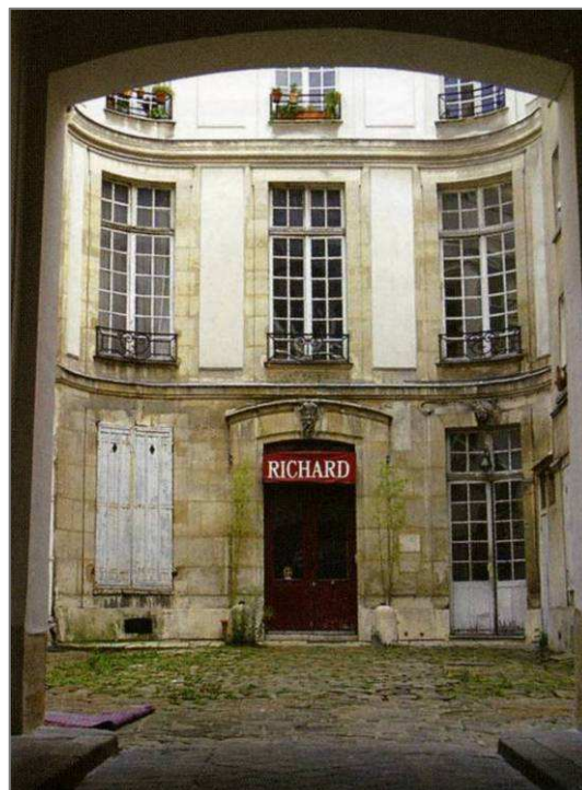
Façade sur cour
