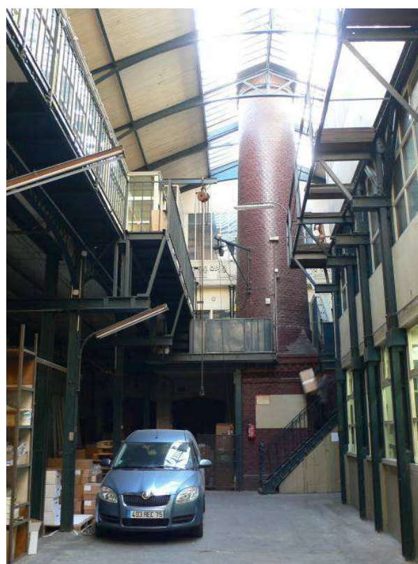
Cheminée de l'ancienne société des cendres, 39 rue des Francs-Bourgeois
