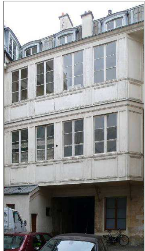
Galerie de liaison à l'arrière de l'immeuble 157 rue du Temple
