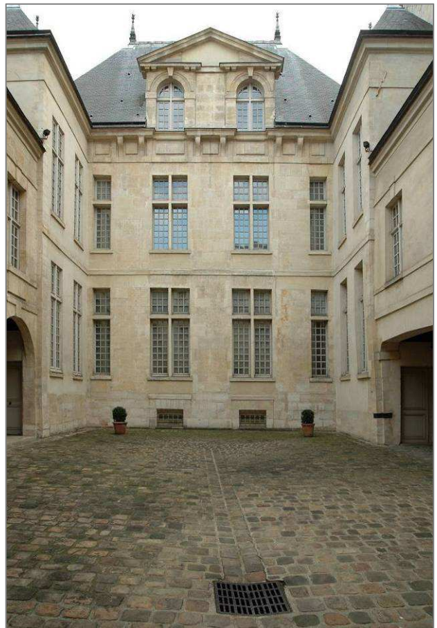
Façade sur cour de l'hôtel de Donon après restauration, aujourd'hui musée Cognacq-Jay.
