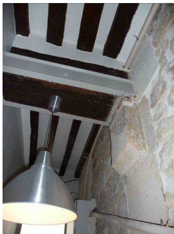
36 rue de Poitou, Plancher à poutres maîtresses
