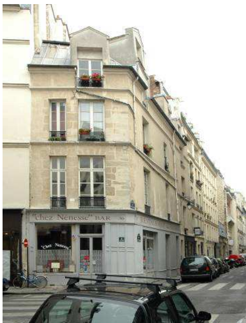
30 rue de Poitou, : lucarnes pendantes maçonneries du XVII e siècle
