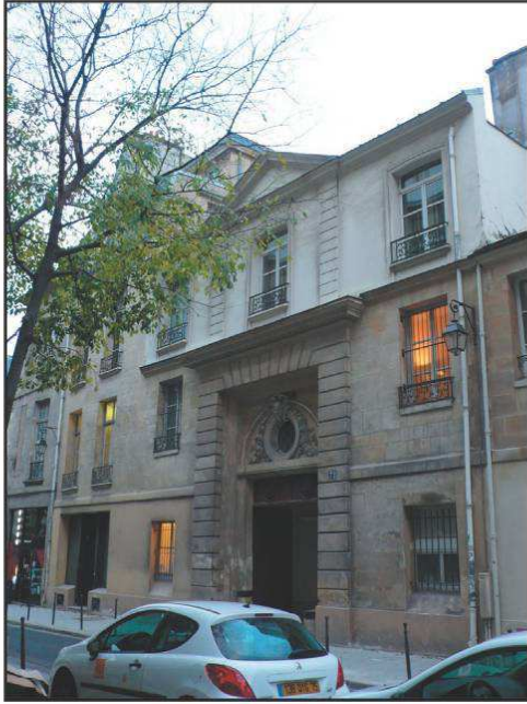
Portail sur rue probablement construit à la fin des années 1650 et surélevé dans la deuxième moitié du 18e siècle.
