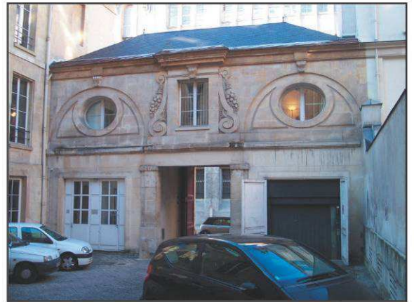
Portail : vue prise depuis la cour.
