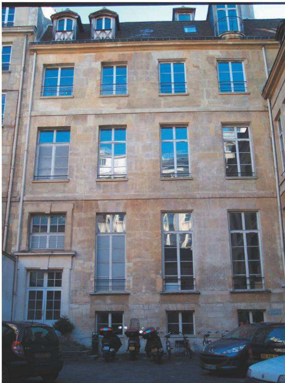
Corps de logis principal entre cour et jardin élevé sur un rez-de-chaussée haut posé sur un étage semi-enterré (destiné aux offices). La façade sobre ne présente aucun décor. Seuls les bandeaux d'étage sont légèrement moulurés.
