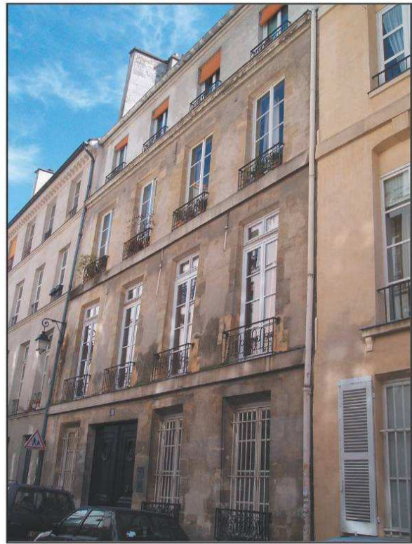
Comme la plupart des maisons de l'ensemble urbain, le n°13 a été surélevé mais a gardé ses bandeaux d'étage.
