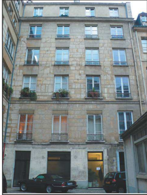
Corps de logis entre cour et jardin surélevé au 19e siècle.
