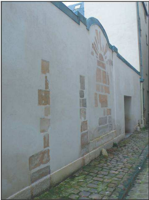
Mur du jardin donnant sur la ruelle Sourdis, dans lequel se lit encore l'emplacement de la porte et de la fontaine.
