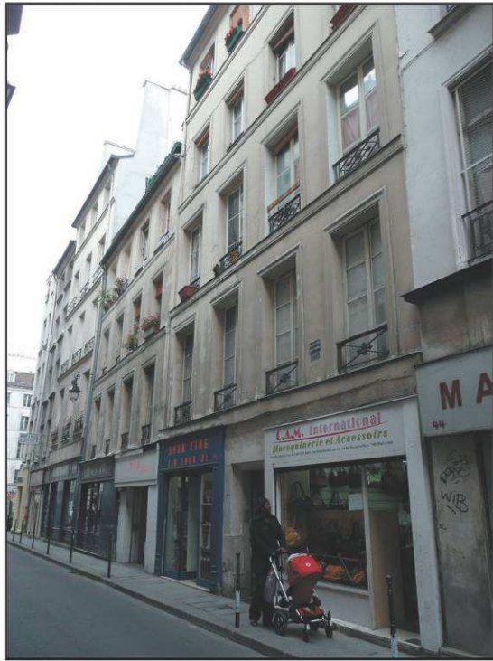
Façade sur rue datant du 17e siècle
