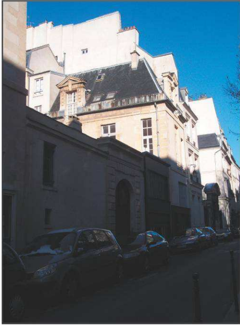
Mur bas percé d'un portail et aile droite sur cour de l'hôtel qui conserve une belle lucarne en pierre.
