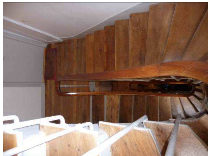
36 rue de Poitou, Escalier à volée à limon suspendu XIX e siècle
