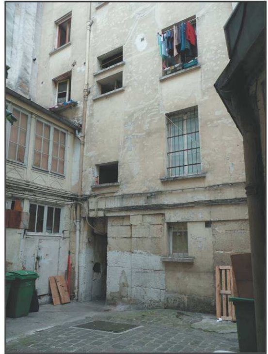
Bâtiment à usage d'atelier dans la cour figurant sur l'Atlas Vasserot
