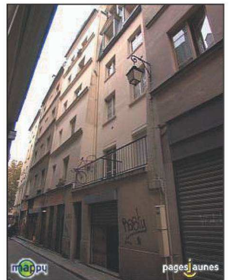
24 à 28 rue des Vertus, vers la rue Réaumur
