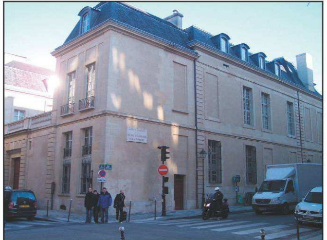
Même façade après restauration par l'architecte en chef des Monuments historiques. Vue prise en 2009. La surélévation construite sur le portail a été démolie, tandis que les ouvertures pratiquées au rez-de-chaussée pour l'ancien commerce ont été rebouchées.
