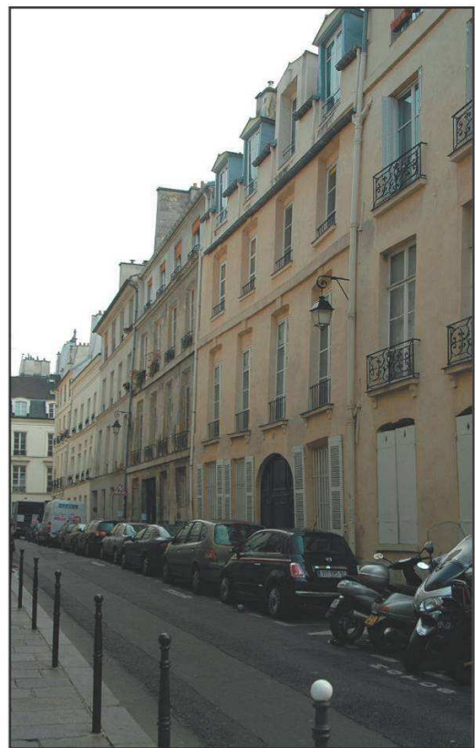
Côté impair depuis la rue de Turenne
