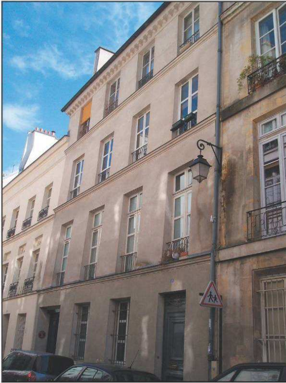
N°11 rue Villehardouin. La porte cochère n'a pas été conservée et la façade a été surélevée vraisemblablement au début du 19e siècle.
