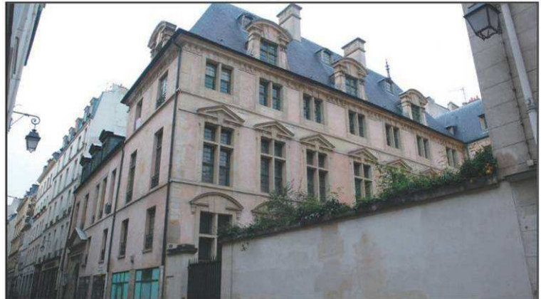
Façade sur rue et aile sur jardin reconstruite lors de la restauration du début des années 1990
