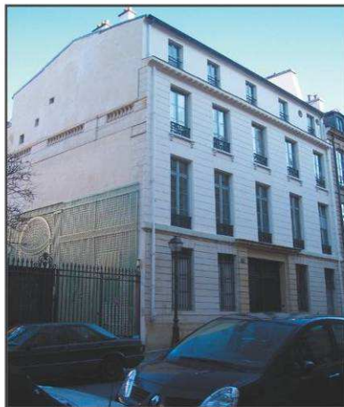
Hôtel Le Féron, 20 rue des Quatre-Fils. Façade sur rue construite dans les années 1730 offrant un bon exemple de style Louis XV (rythme et décor des baies cintrées à clefs, porte cochère surmonté d'un mascarón).
