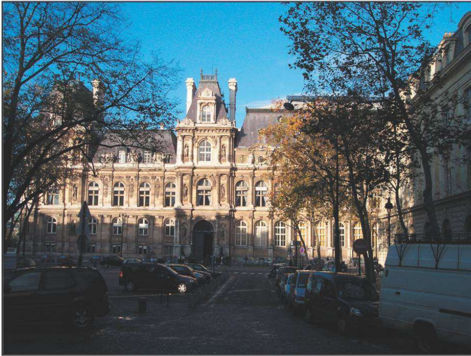
Façade néo-Renaissance de l'Hôtel de Ville reconstruit au début des années 1880. Vue prise depuis la rue François-Miron.
