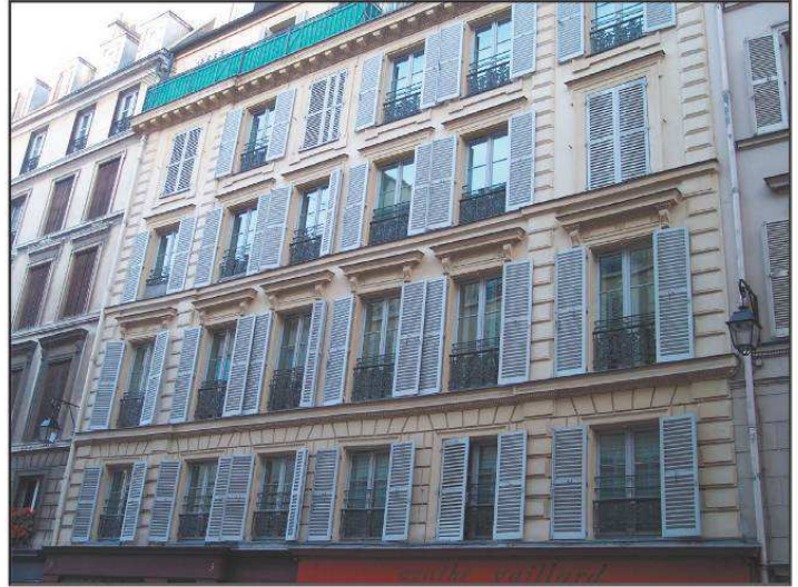
Immeuble du 3 rue du Pont Louis-Philippe. Le dernier niveau ren retiré est plus proche de l'immeuble qui se développera au cours des années 1830-1840. On notera ici les persiennes.
