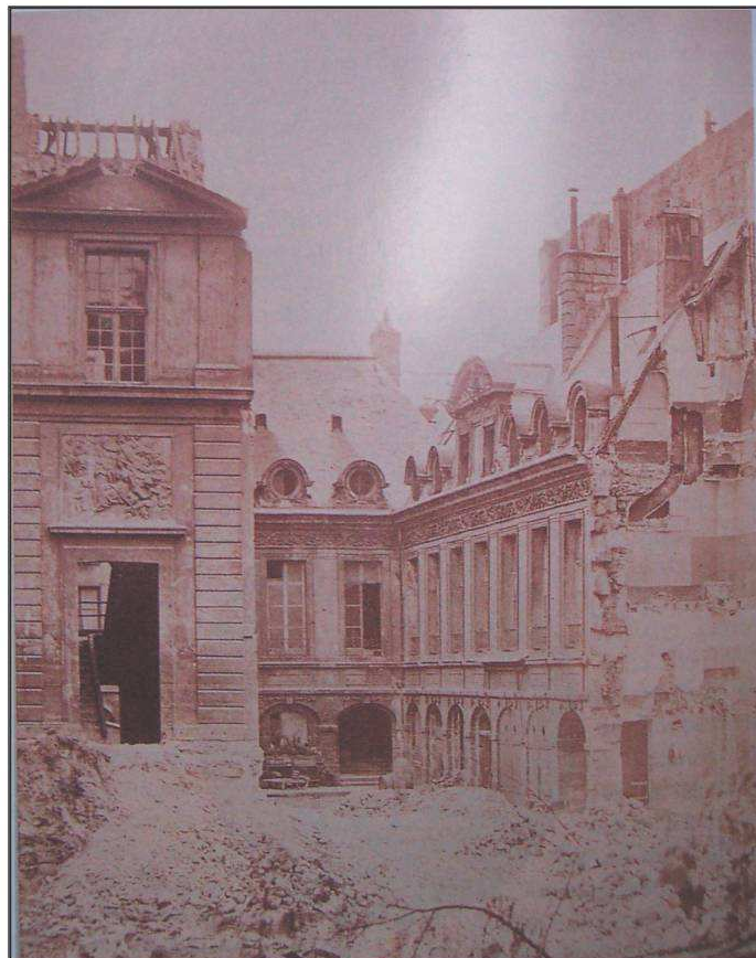
L'ancien hôtel d'Effiat en cours de démolition, phot. H. Godefroy, 1882.
