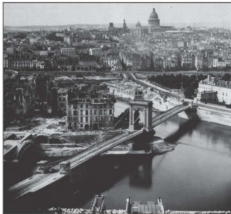
Vue panoramique depuis le clocher de l'église Saint-Gervais montrant l'ancien pont suspendu et le nouveau pont Louis-Philippe en chantier.
