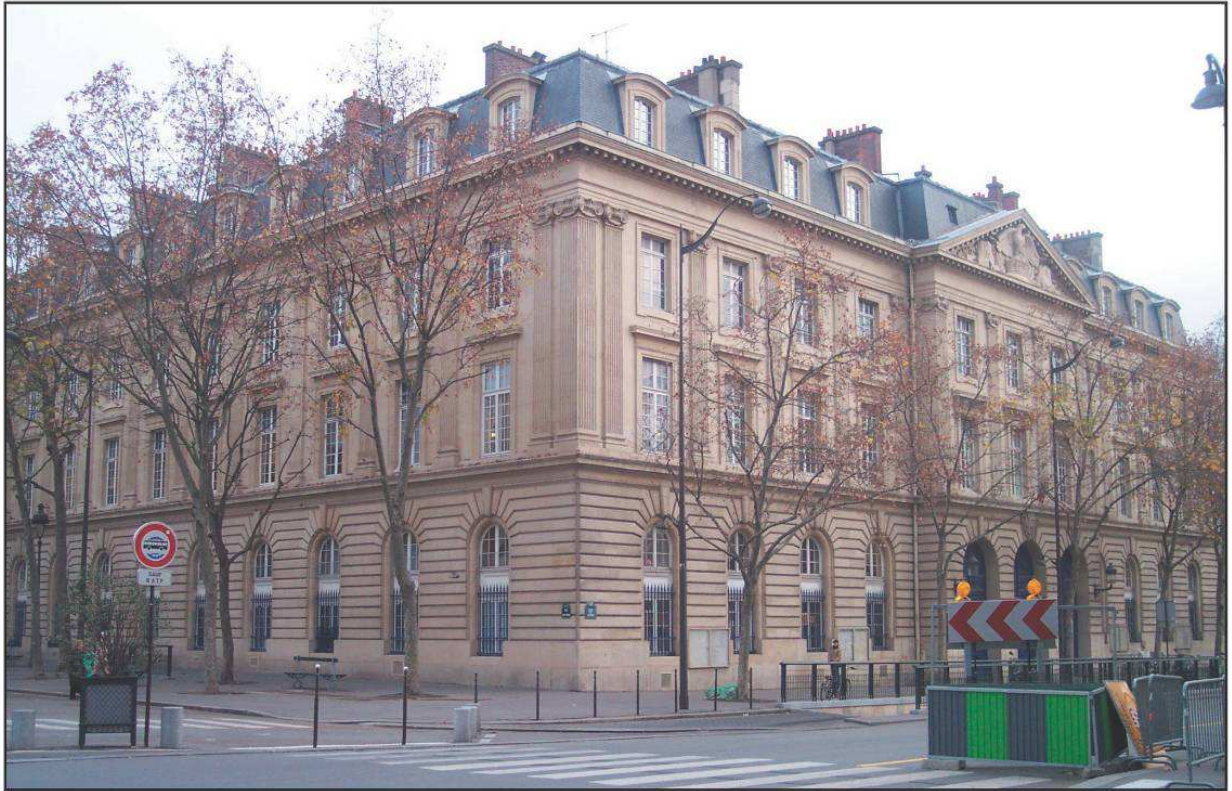
Façade principale de la caserne Lobau (2 rue Lobau)
