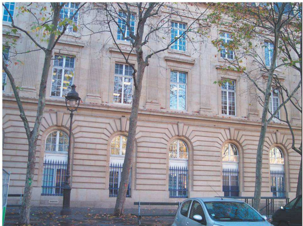
La façade de la caserne Lobau donnant sur la place Saint-Gervais. Le soubassement à refends, les pilastres engagés et l'avant-corps surmonté d'un fronton triangulaire rappellent les façades de la place Vendôme.
