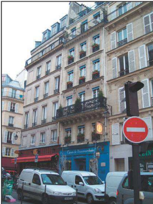
12 rue Vieille-du-Temple. Maison ancienne épargnée par les travaux de prolongement. La façade a été rhabillée à la fin du 19e siècle.
