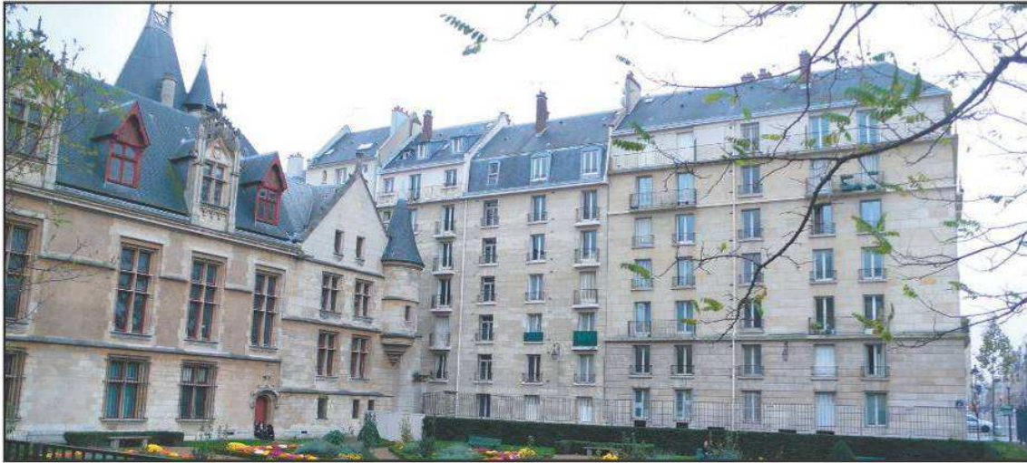
Façade arrière de l'îlot quai des Célestins / rue de l'Hôtel de Ville et jardin restitué de l'hôtel de Sens.
