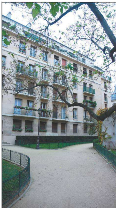
Immeubles de la Société d'HBM de Paris et sa région (Benoît Danis, architecte 1956) dans l'îlot Charlemagne, Figuier, Fauconnier.
