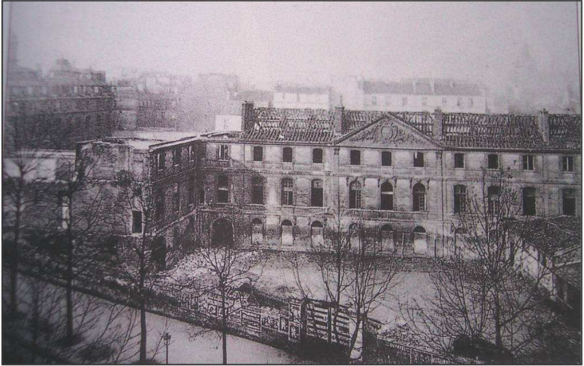
La caserne en cours de démolition en 1904.
