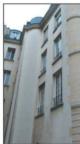
Maison du Château-Frileux (1755), 21 rue du Figuier: exemple de rénovation d'un bâti ancien dont la façade a été conservée et les intérieurs repris. Le pan coupé arrondi (angle de la rue Charlemagne) a été imité sur la partie gauche. Ci-dessus, détails : invention d'une meurtrière et d'une tour-escalier (Birr, architecte, 1951).
