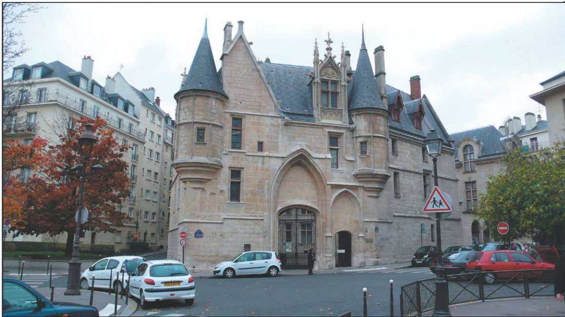
Hôtel de Sens : façade rue du Figuier. A gauche : immeubles de logements (Béguin, architecte).
