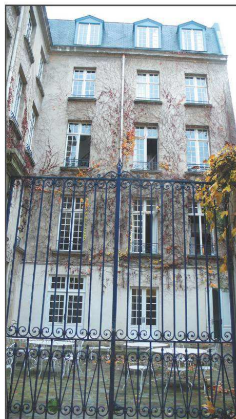
Façade arrière de la maison 17e du 11 rue du Fauconnier, dont la façade a été conservée et l'ensemble restauré. Les ferronneries «à la manière de» datent des années 1950.
