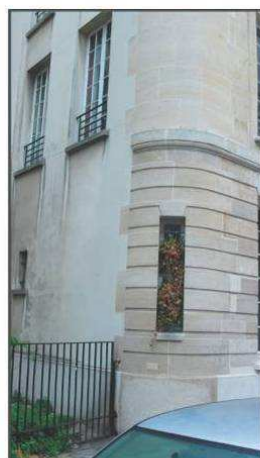
Maison du Château-Frileux (1755), 21 rue du Figuier: exemple de rénovation d'un bâti ancien dont la façade a été conservée et les intérieurs repris. Le pan coupé arrondi (angle de la rue Charlemagne) a été imité sur la partie gauche. Ci-dessus, détails : invention d'une meurtrière et d'une tour-escalier (Birr, architecte, 1951).
