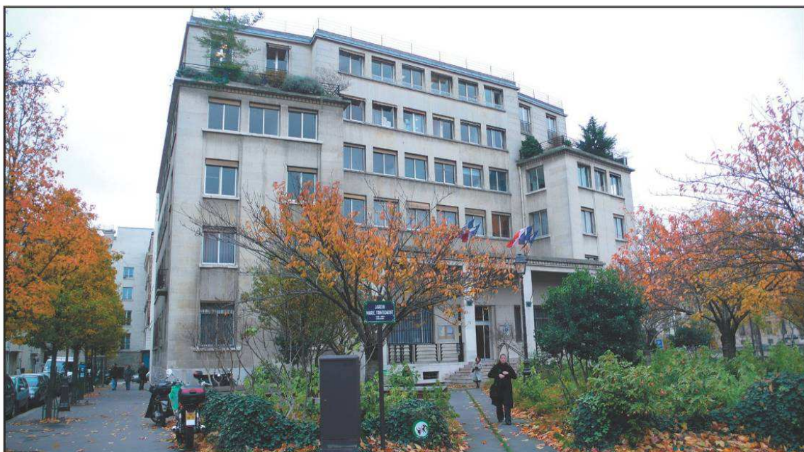
Siège de l'OPHBMS (Bassompierre, Sirvin, de Rutté, architectes, 1933).
