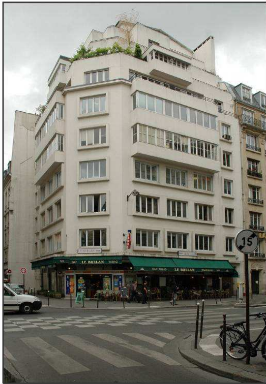
Immeuble des années 1930 du 58 rue Beaubourg
